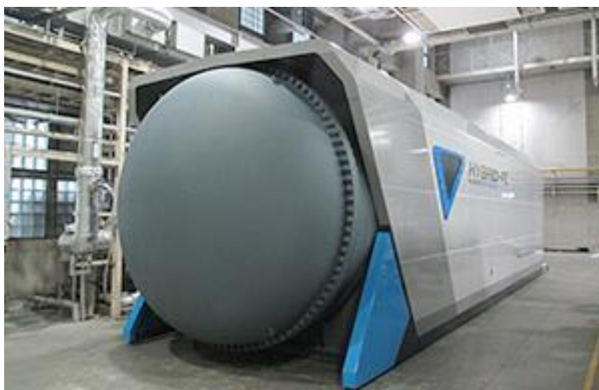
図 3.28 東京ガス千住テクノステーションに設置された 250 キロワット級 SOFC
