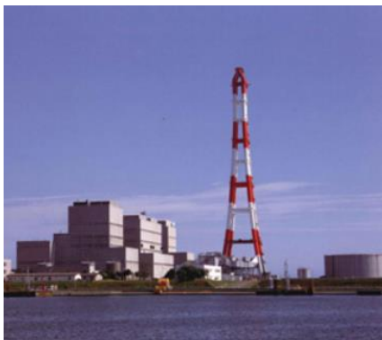
苫小牧発電所
